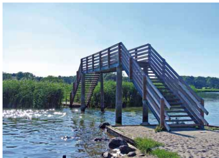
An dieser Brücke wurde fälschlicherweise das Geländer abgesägt.
